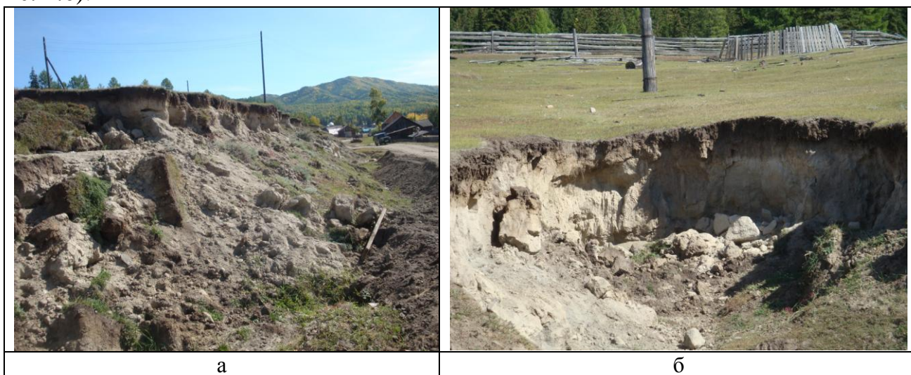
Рис. 2.6 а – обрушения грунта с образованием промоин в восточной части с. Сизим, б – продвижение верхушки оврага в восточной части с. Сизим
